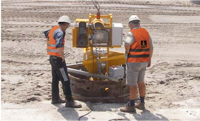
Seilneig beim Einsatz auf der Baustelle
