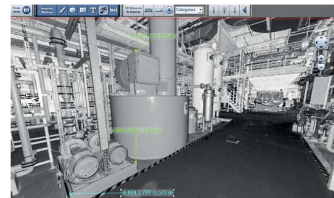
Aufmaß einer bestehenden Reinigungsanlage
