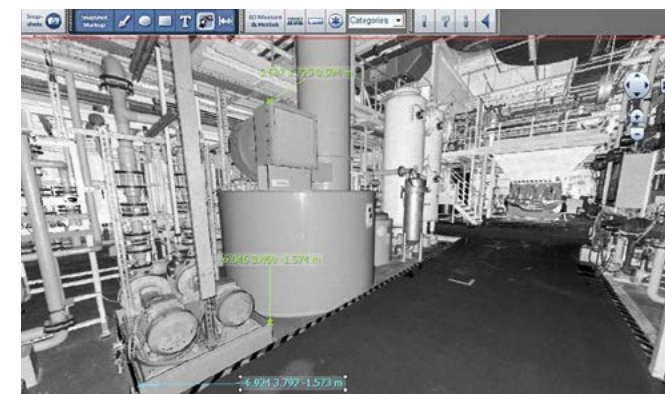
Aufmaß einer bestehenden Reinigungsanlage
